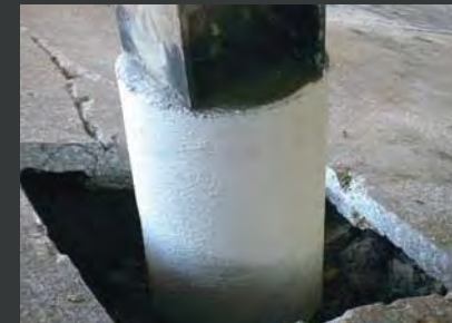
Sección después del reforzamiento con PileMedic®.
