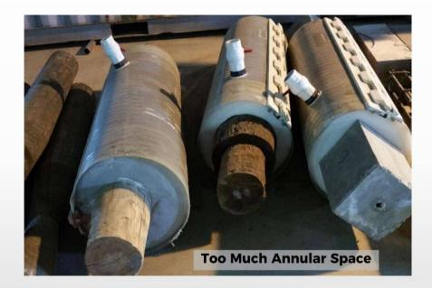
Les systèmes de gaines pour les pieux plus anciens sont de tailles standard. Ces tailles standard conduisent à des espaces annulaires plus grands qui ajoutent une charge morte au pieu et augmentent la quantité de coulis et les temps d'installation.
